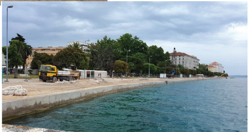
Zara oggi: la Riva Nuova fotografata dal molo verso nord e verso sud durante i recenti lavori di manutenzione e rifacimento (foto Dalmi Politeo)
